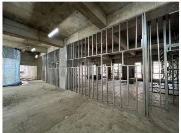
2 樓 MOCKUP 輕隔間骨架安裝
