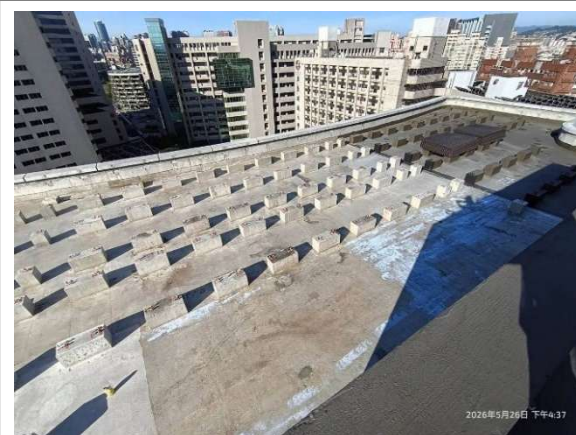
屋頂樓板防水
